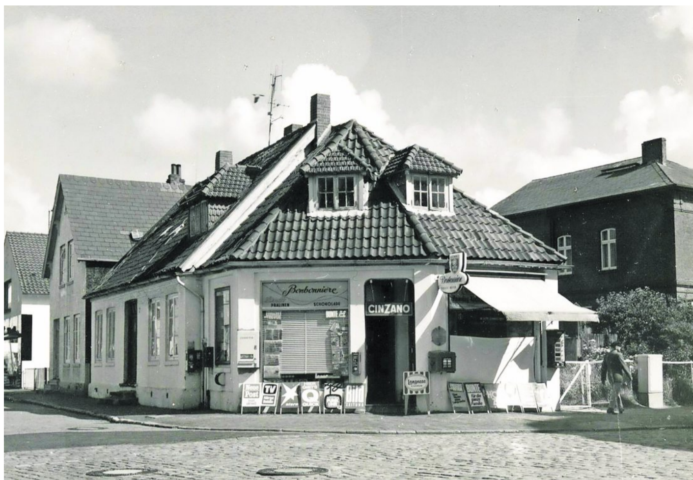
In der Blohmstraße 5 in Cuxhaven (Ecke Grüner Weg, hier im Juli 1971), befand sich das DKP-Büro. Themen damals, so Wietzer: Frieden und Abrüstung, Arbeitsplätze in der Werftindustrie, kommunale Fragen sowie Demokratieabbau und Berufsverbote. Das Haus wurde 1987 abgerissen. Foto: Stadtarchiv Cuxhaven (H. Schönemann)
